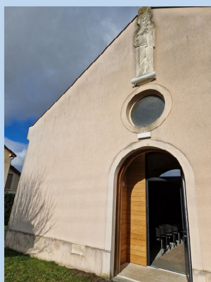
Nouvelle entrée de la chapelle
